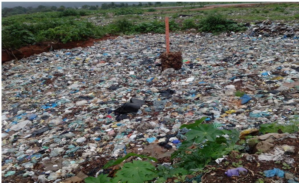
Figura 2 - Célula utilizada para disposição final dos resíduos sólidos no aterro controlado de Conceição do Araguaia.
